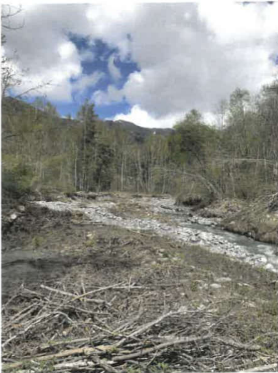
La Blanche du Fau en amont du pont de la D 900 ; ce tronçon du cours d'eau a fait l'objet de travaux d'urgence en novembre 2020.
