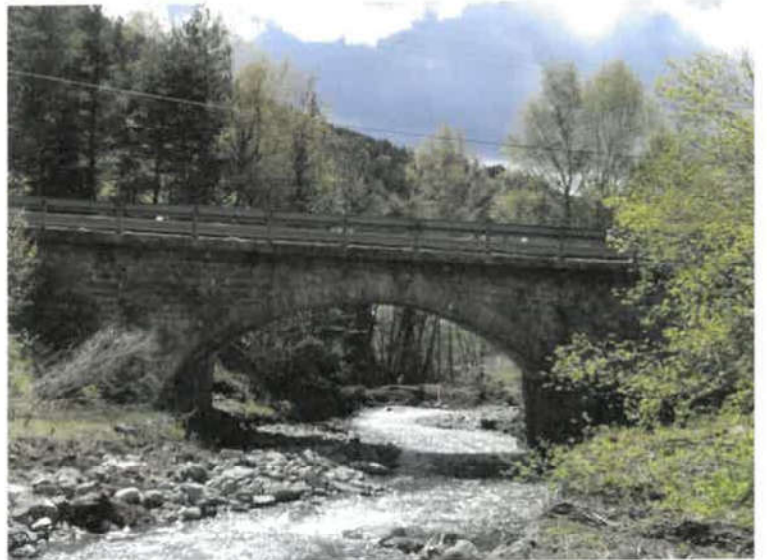
Le pont sur la D900 ; en l'absence des travaux d'urgence, l'ouvrage aurait vraisemblablement été endommagé par une énorme amas d'embacles suite à la crue exceptionnelle du 11 mai 2021 de fréquence trentennale selon l'agence de l'eau.
